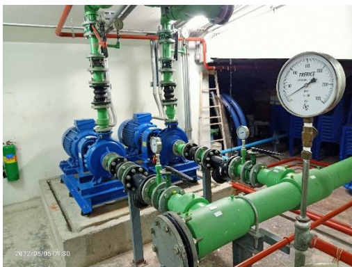
ปั๊มสูบน้ำประปาขึ้นไปยังถังเก็บน้ำชั้นดาดฟ้า
